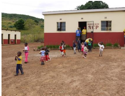
Das einfache Gebäude eines NCPs
